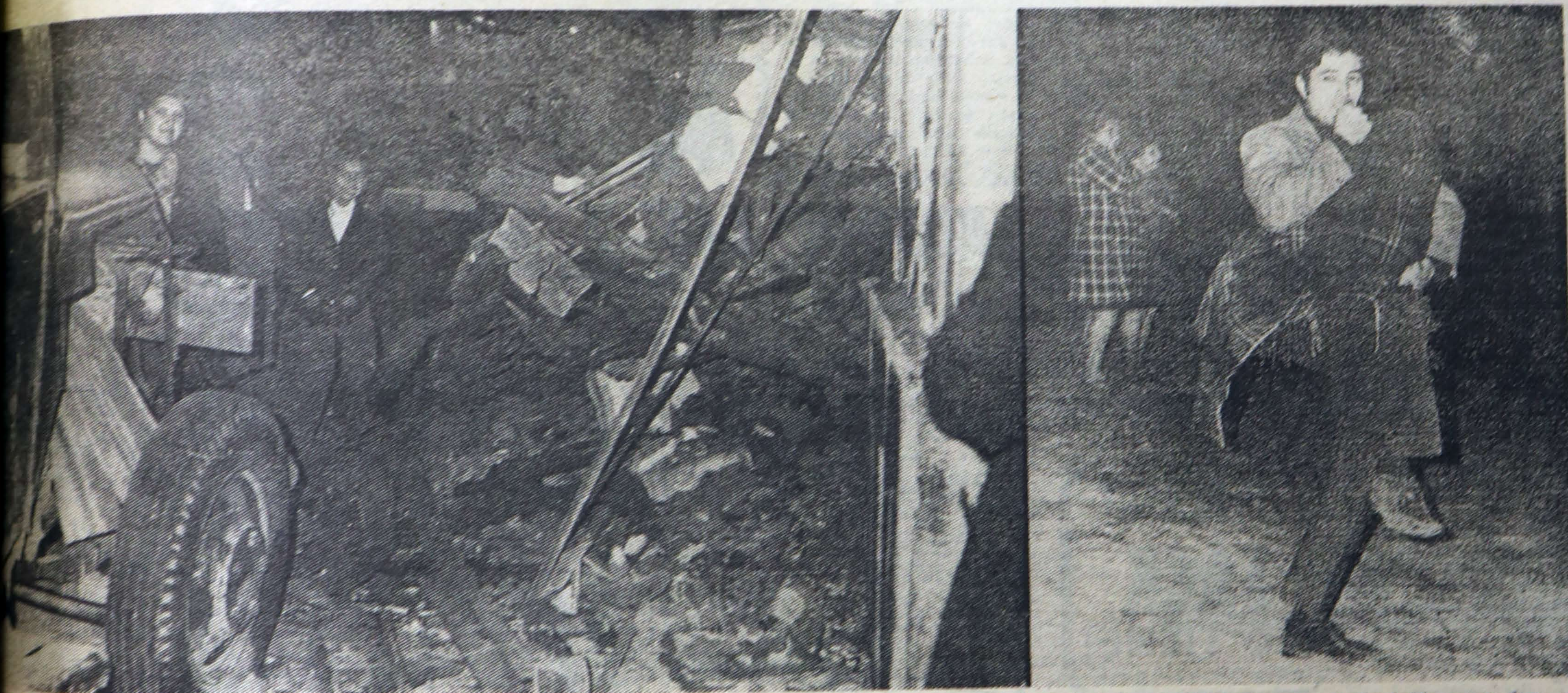
EN SAN PABLO 1909 se desplomó una casa. Felizmente nadie la habitaba, pues su dueño había muerto hace una semana. AL LADO: un padre, presa de pánico, bajó su guagua envuelta en una manta.
